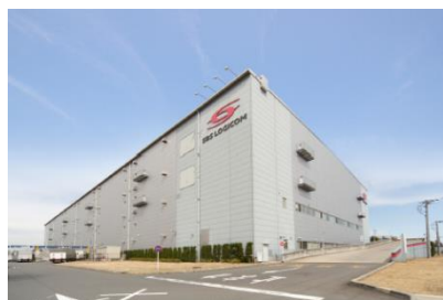
埼玉・川越物流センター 2007年11月竣工
