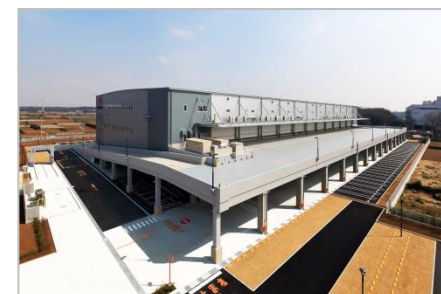
竣工した埼玉・所沢物流センター
