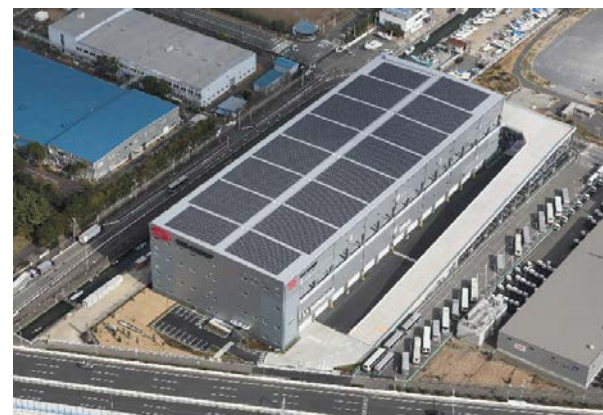
SBSロジコム新杉田物流センター 屋上に設置した太陽光発電設備 (2016年2月竣工)
