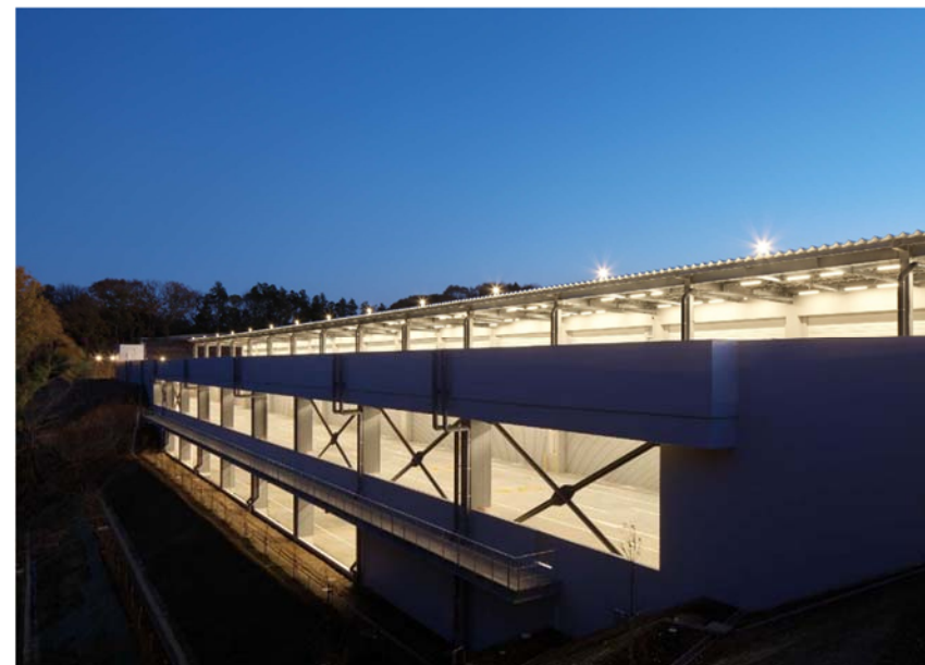
北側からトラックバースの夜景
