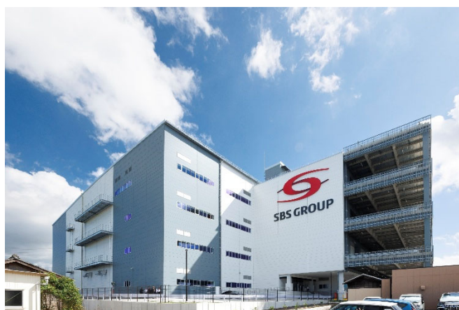
富里物流センター外観
