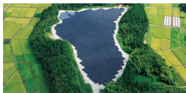
芝山太陽光発電所上空からの写真
