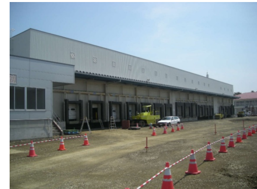
復旧した岩沼物流センター
