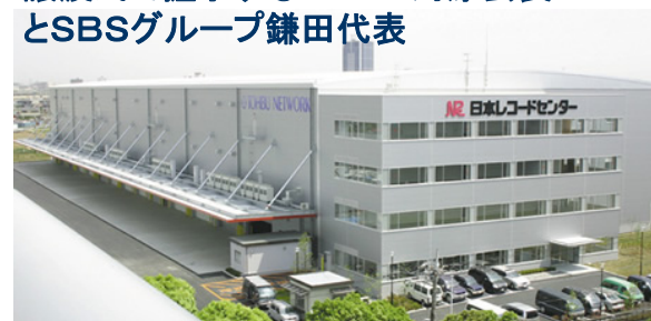
本社・上落合DC全景(神奈川県厚木市)
