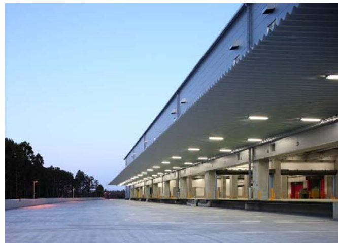
2階トラックバース
