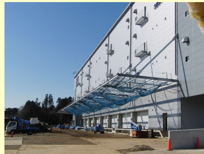
完成間近のトラックヤード
