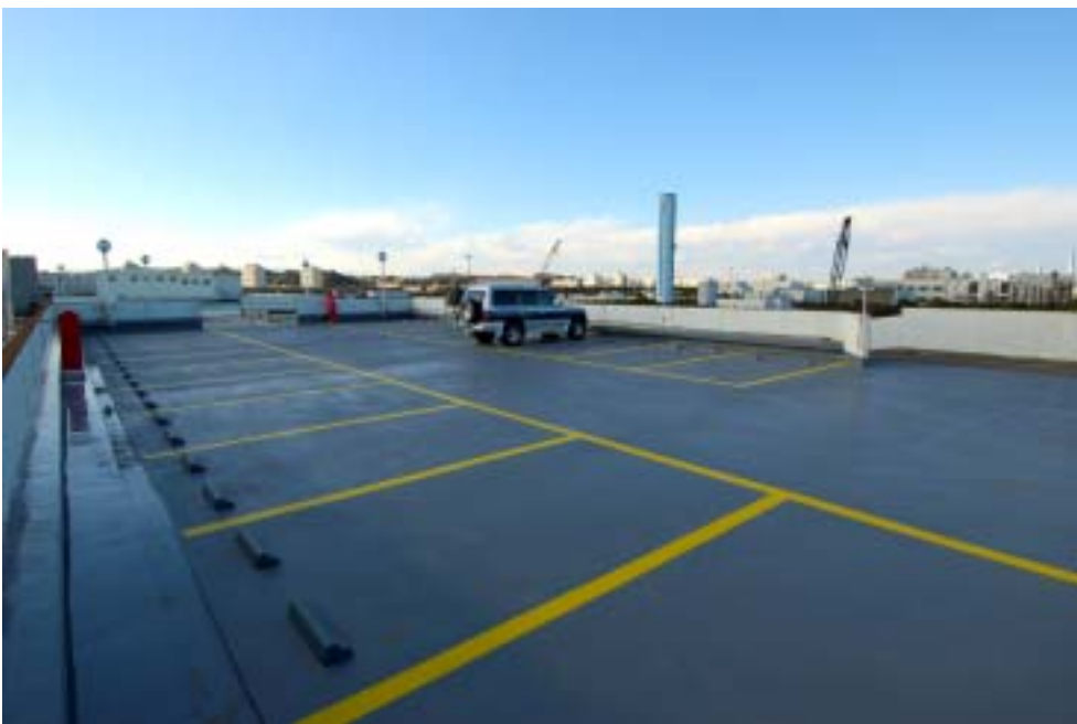
施設屋上駐車場
