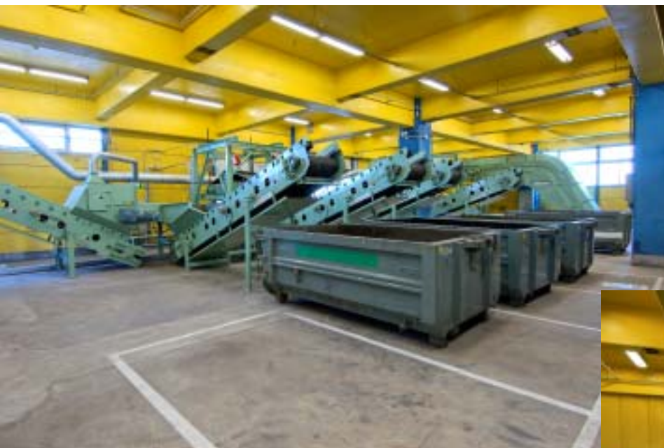
処理設備(ベルトコンベアと回収カーゴ)
