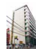
渋谷新南口ビル (オフィスビル) 敷地面積: 1,416㎡ 延床面積: 9,013㎡ 竣工: 2000年1月
