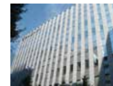
南新宿SKビル (オフィスビル) 敷地面積: 1,143㎡ 延床面積: 7,531㎡ 竣工: 1997年7月
