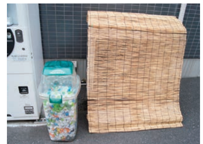
エコキャップの回収とよしずによる室外機の温度上昇の抑制
